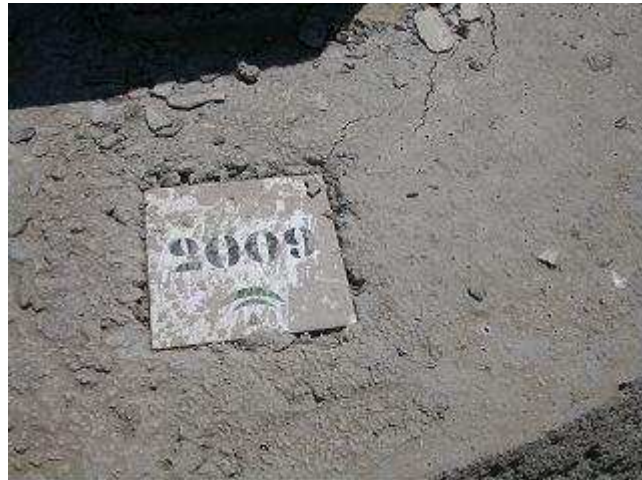
Imagen nº6. Detalle placa cerámica encastrada. Colocación correcta.
