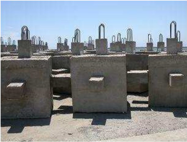
Imagen nº3. Módulo disuasorio en el puerto de Motril en actuación precedente.
